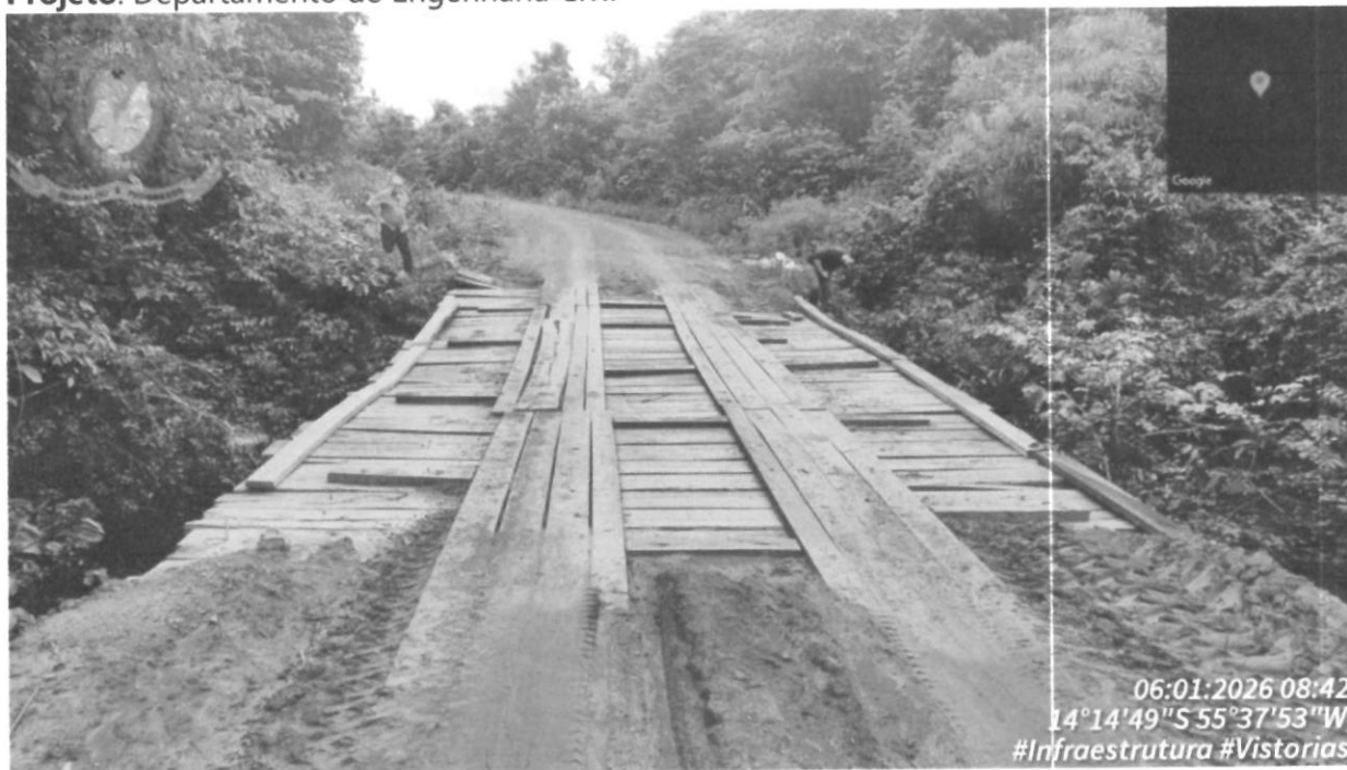
Figura 1-Ponte do Pantanalzinho (Larg.=5m; Comp.=13m)
